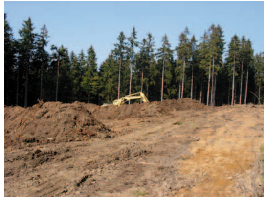
Abb. 8: Haiger »Kalteiche« – Waldrodung im Vorfeld der Einrichtung eines Rotorenstandortes
