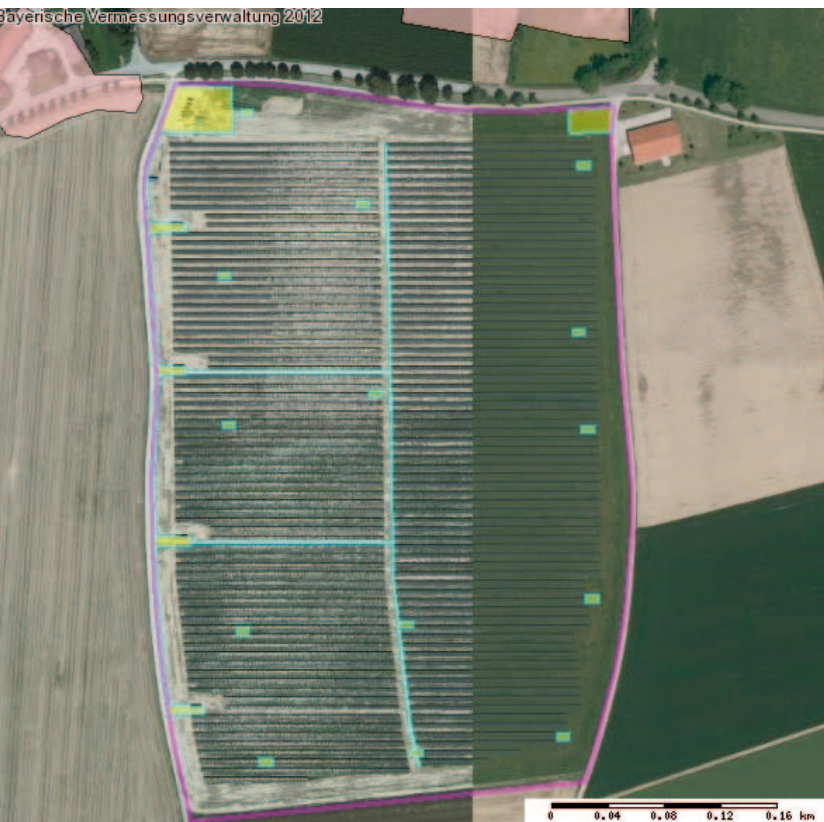
Abb. 6.: Untersuchte Kabeltrassen und Trafostationen einer PV-Anlage in Maisach, Lkr. Fürstenfeldbruck
