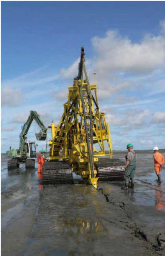
Abb. 4: Wattkabelverlegung mit dem Vibrationspflug
