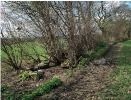
Abb. 4: Bereits erheblich zerstörtes Denkmal Kosel DB 1 in einem Knick. Das Denkmal ist zu erhalten, ein besonderer Umgebungsschutz ist nicht zu berücksichtigen.
