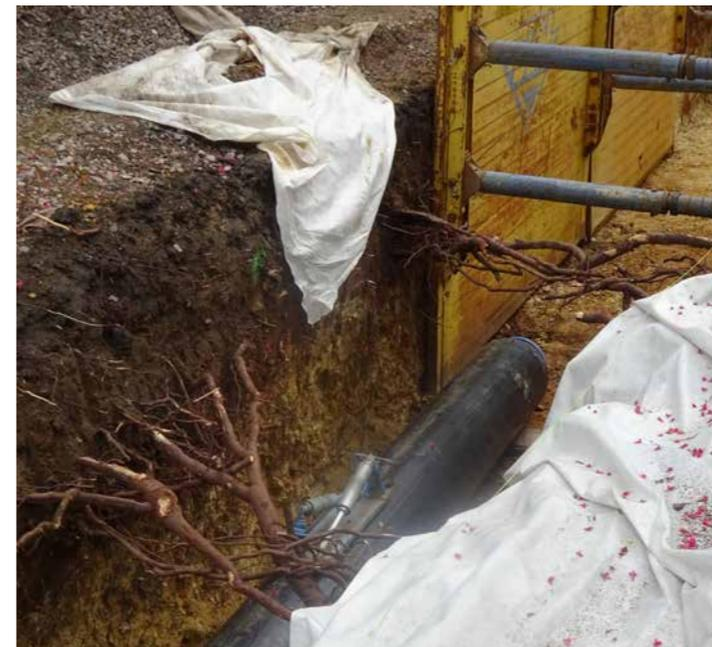
Verlegung einer Fernwärmeleitung unter Erhalt der Wurzeln vor Ort
